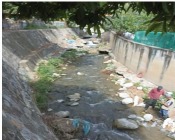
Socavación total de la losa de fondo en quebrada las Naranjas
